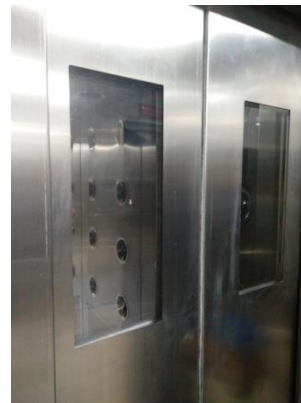
风淋室 エアシャワー
